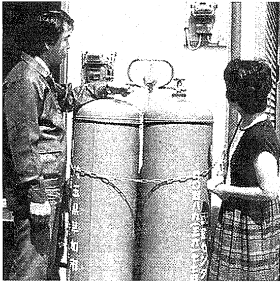
LPガスはボンベによる個別供給のため、被害を最小限に抑えられる
