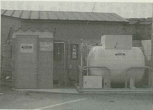
災害用バルクと備品を収納した倉庫
