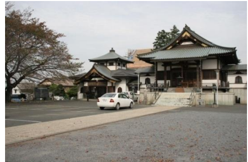
＜奥に見える茶色い屋根が建設中の本堂 来年秋落慶予定＞
