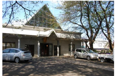
＜観音堂正面 この裏にバルクを設置＞
