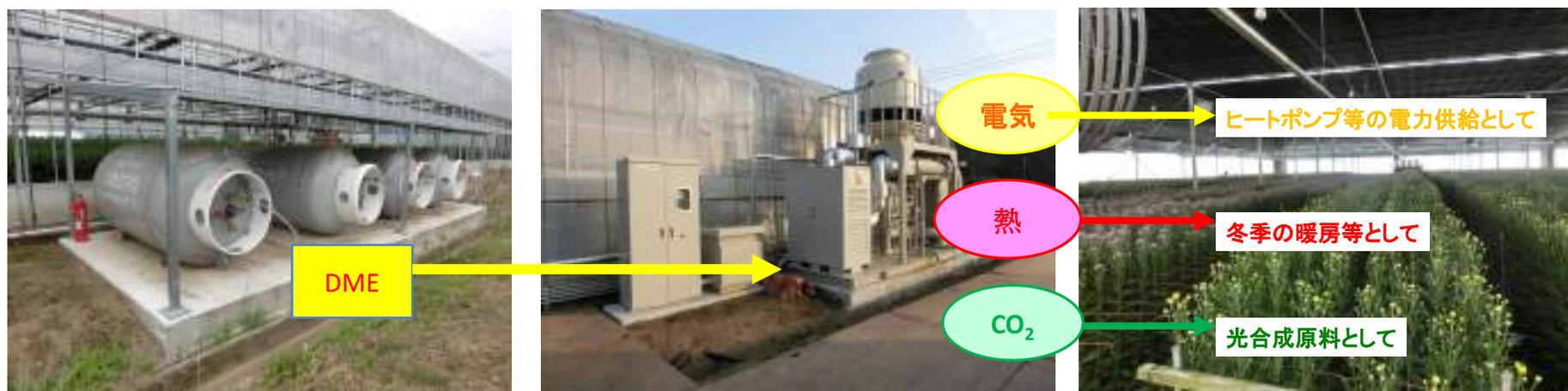
※ トリジェネレーション（トリジェネ）とは、コジェネ（熱電供給）+CO<sub>2</sub>供給を行うシステム
