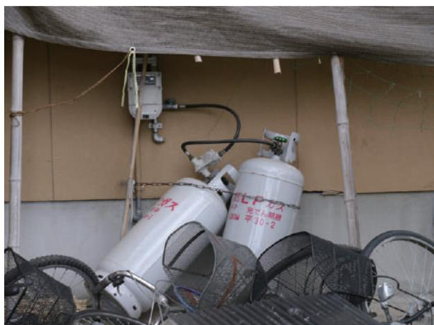
家屋が倒壊しLPガス容器が転倒（熊本県益城町）
