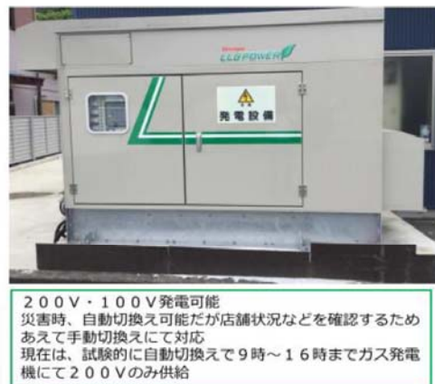
図 2.7 災害時対応店舗に備えられたガス発電機及び受水槽
