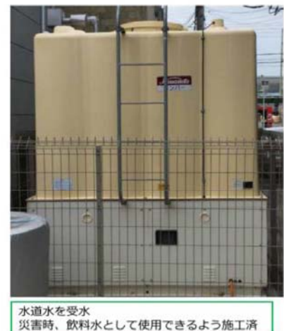
図 2.7 災害時対応店舗に備えられたガス発電機及び受水槽
