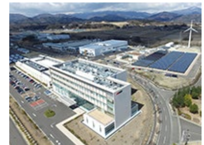
福島再生可能 エネルギー研究所
