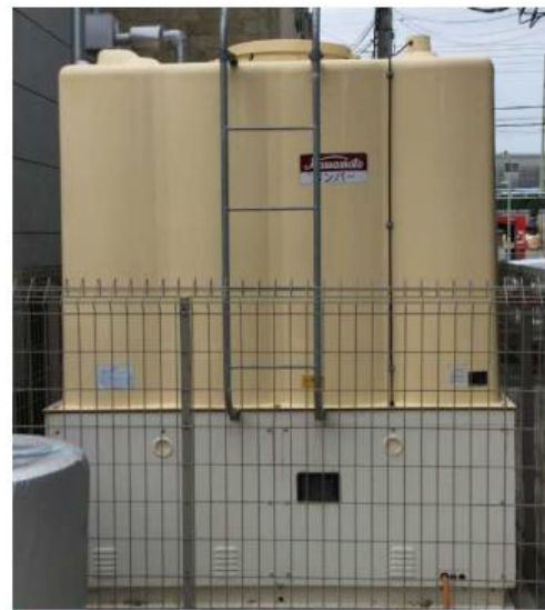
図 2.7 災害時対応店舗に備えられたガス発電機及び受水槽
