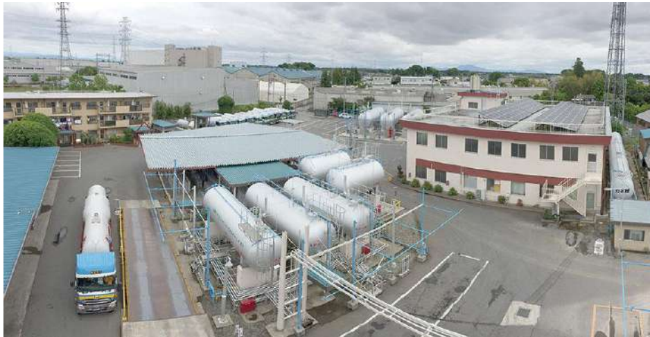
図 4.4 陽品運輸倉庫 野田事業所全景
