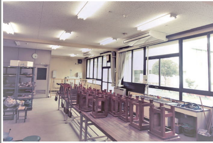
特別教室は面積が広いので2台の室内機を設置
