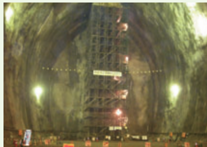
▲波方基地(地下備蓄)
