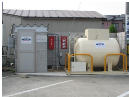
<災害用バルクと備品を収納した倉庫>
