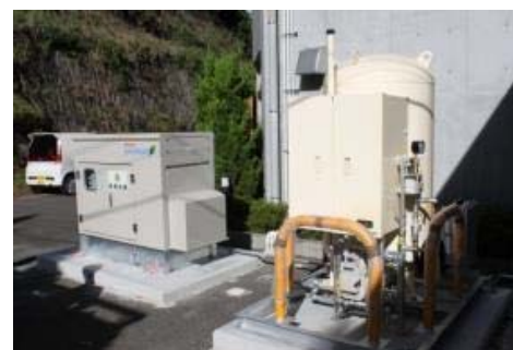
LPガス災害対応バルクと設置例
