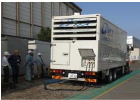
輸入基地における移動式電源車の 接続訓練
