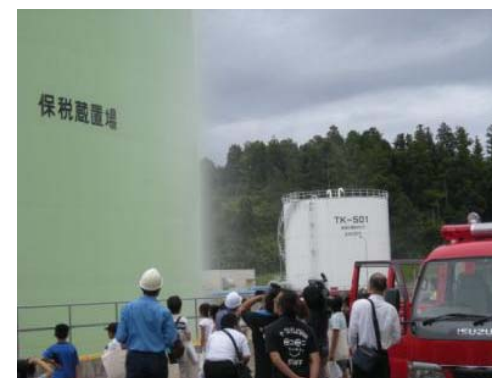
低温タンク放水
