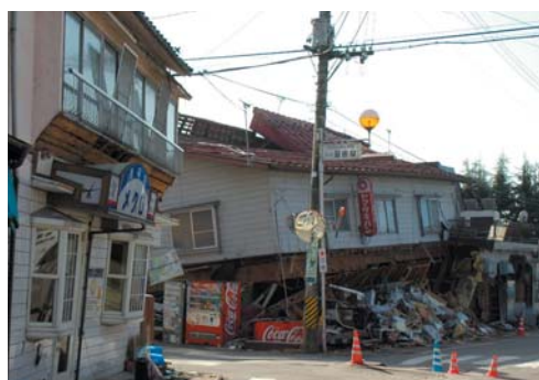
写真提供：(株)石油化学新聞社 (新潟県中越地震)
