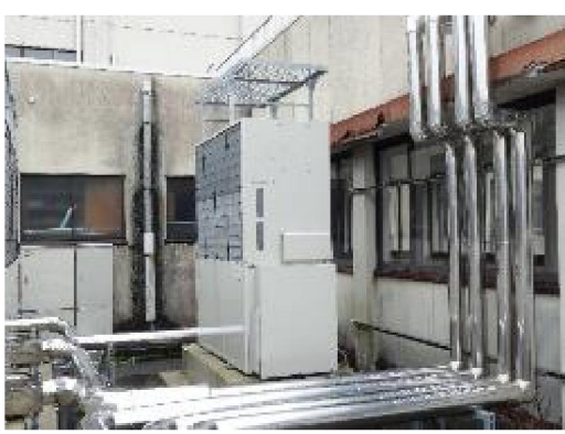
同左 電源自立型GHP施設
