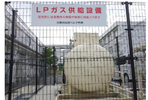
奈良県三宅町小学校への災害対応型バルクの設置
